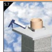
Siūlę tarp dengiamosios ir metalinės izoliacinės plokštės užtaisykite silikoniniu hermetiku.
